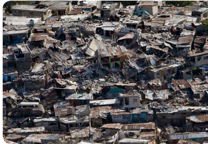
Haiti Earthquake/UN Photo/Logan Abassi / Wikimedia Commons
